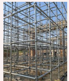
Shuttering Pipe 20000 Nos.
