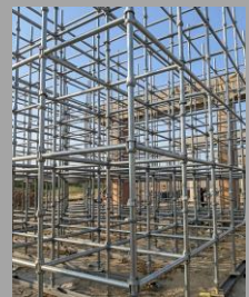
Shuttering Pipe 20000 Nos.
